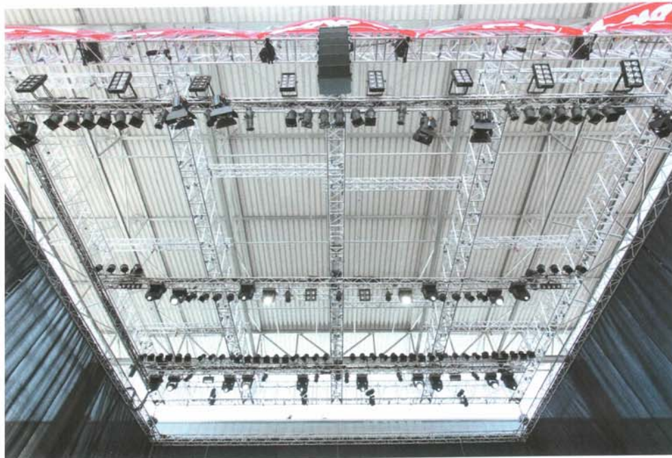
Ein Blick in das Bühnendach mit brandneuen Traversen
